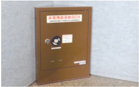
▲在总部室内电梯内设置应急储备品的例子
